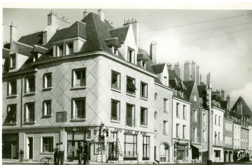
Gien, l'immeuble du « Corto » au début des années 1950, source anabf.org
