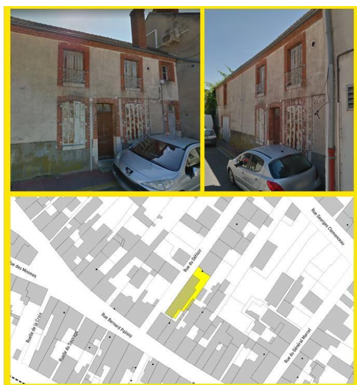
Situation au 4 rue du Défiloir
