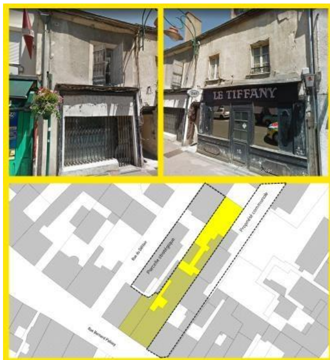
Situation au 76 (photo de droite) et 78 (photo de gauche) rue Bernard Palissy
